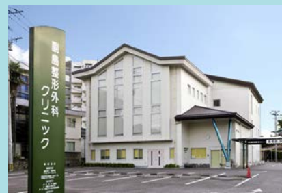
副島整形外科クリニック
