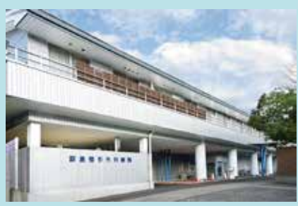
副島整形外科病院 佐賀県武雄市武雄町大字富岡 7641 番地 1 ☎ 0954-20-0388 FAX:0954-20-0377
